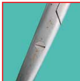
Пример язвенной коррозии
