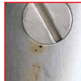
Пример язвенной коррозии
