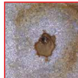
Пример язвенной коррозии
