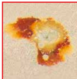
Пример язвенной коррозии
